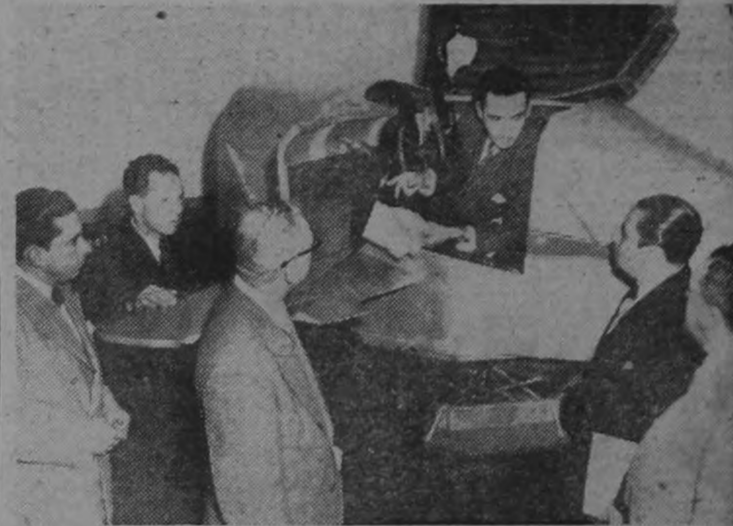
Ante la Comisión Legislativa, el piloto aviador Mannel E. Guerra explica, acompañado de Guillermo Núñez, el funcionamiento del "entrehador Link", para vuelo a ciegas, que forma parte del moderno equipo con que cuenta la compañía para la seguridad del público.
